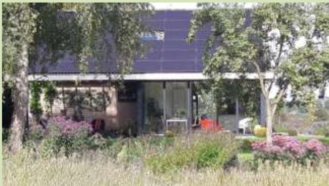
Een dak vol zonnepanelen
